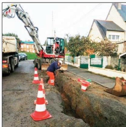
L'enfouissement des réseaux électriques et téléphoniques est réalisé. Les travaux ont été réceptionnés par Orange ce qui amène à l'étape de l'enlèvement des poteaux. Cette étape réalisée, l'entreprise Colas interviendra pour les travaux sur la chaussée.
